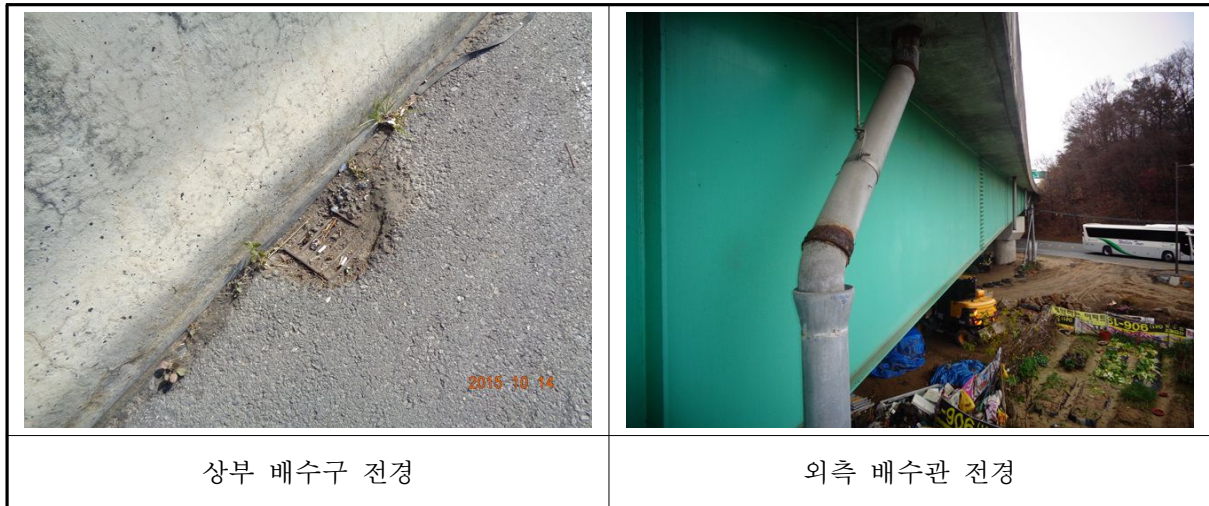
〈사진 3.6〉 배수시설 전경
