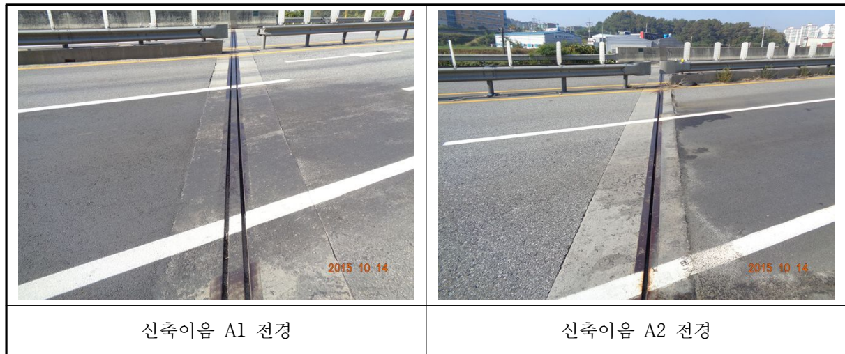
〈사진 3.8〉 신축이음 전경
