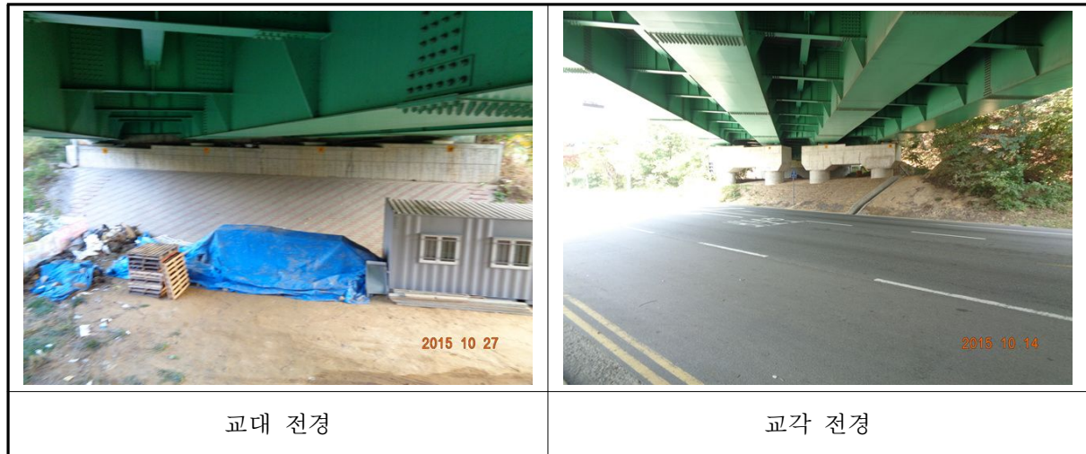
〈사진 3.17〉 교대 및 교각 전경
