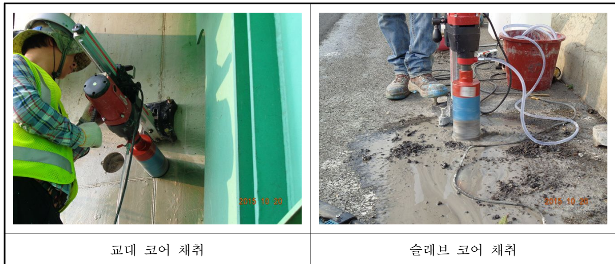
〈사진 3.20〉 압축강도 시험 현황
