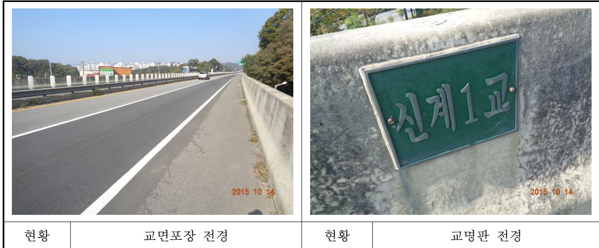
〈사진 3.2〉 교면포장 전경
