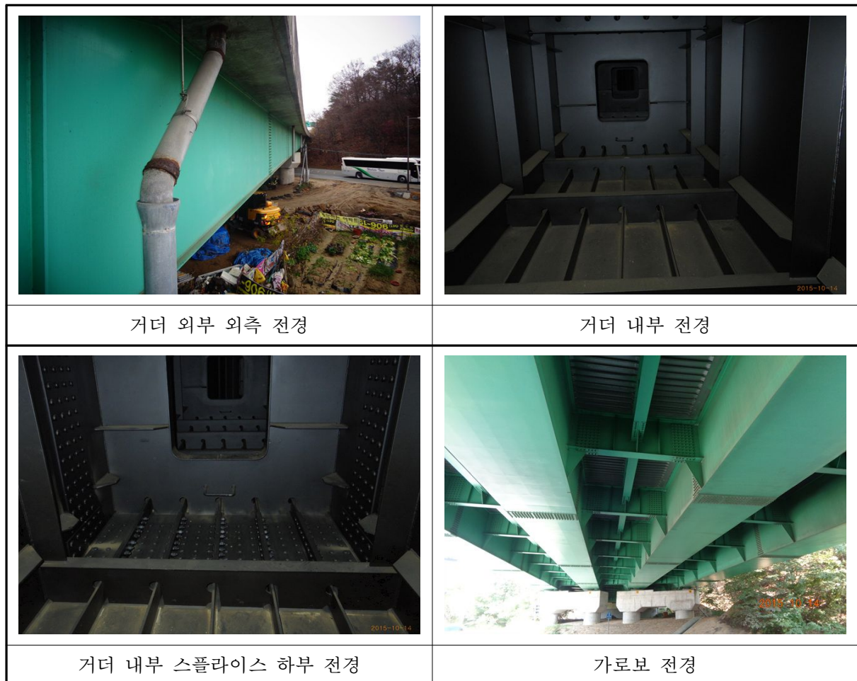
〈사진 3.13〉 거더 및 가로보 전경
