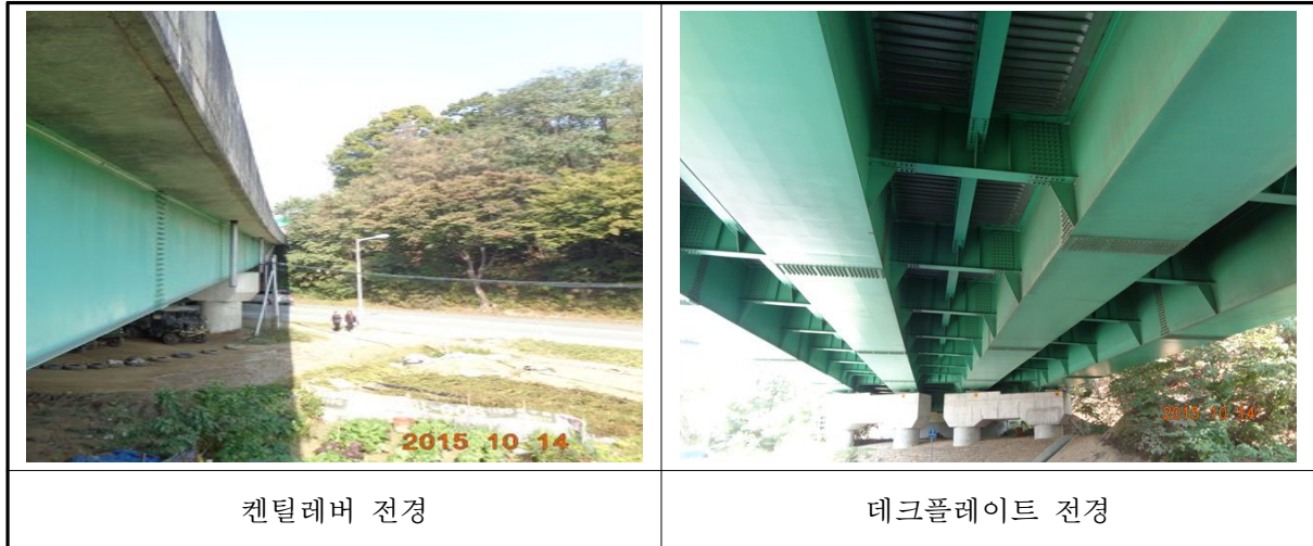
<사진 3.11> 바닥판하면 전경
